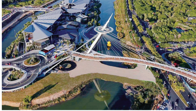
連接一期和二期的景觀橋
